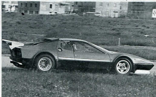
Elio De Angelis prova la Chevron-Ferrari dotata di presa d'aria anteriore maggiorata. Sotto e in basso, la 512 BB per Le Mans con le più recenti novità aerodinamiche
